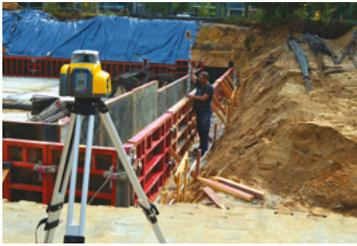
Der Horizontallaser ermöglicht präzise, vollautomatische Nivellierarbeiten über kurze, mittlere und große Entfernungen. Neben der hohen Robustheit und Zuverlässigkeit bietet unser Gerät eine intuitive und einfachste Bedienung.
