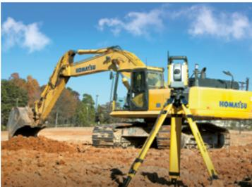
Die Positionierung mit der Totalstation garantiert höchste Genauigkeit bei der Oberflächenkontrolle und beim Materialeinbau und ist dort einsetzbar, wo der Satellitenempfang nicht möglich oder gestört ist (Innenstadtlagen, Abschirmung durch hohe Bäume, Tunnelbau, Schluchten, Gebirge, o.ä.).
